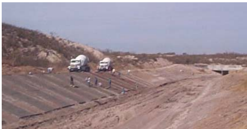
Figura 5. Inicio del proceso de revestimiento del canal Conchos
