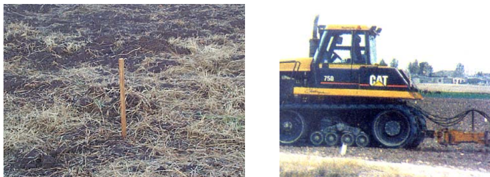
Figura 7. Inicio del proceso de nivelación de tierras
